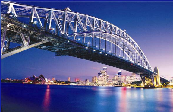
桥梁和建筑监控
