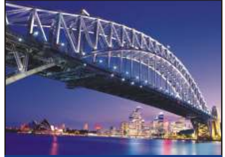
Köprü ve Bina Kontrolü
