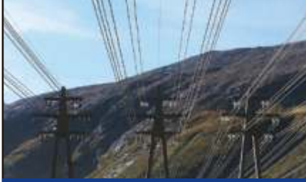
Enerji Hattı Kontrolü
