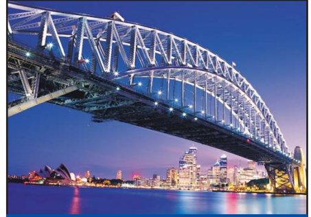
Köprü ve Bina Kontrolü
