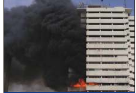
Bina Yangın Tesbiti
