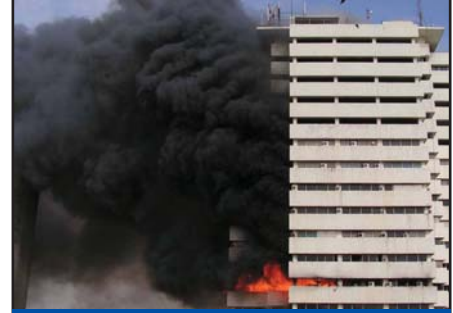
Bina Yangın Tesbiti
