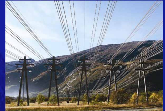
电力线路监控
