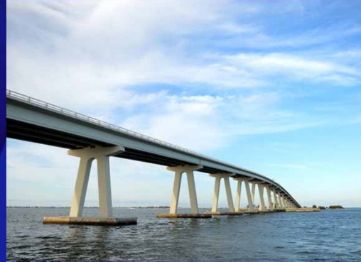
桥梁和建筑物的监测
