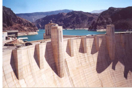
Мониторинг дамб, плотин и насыпей
