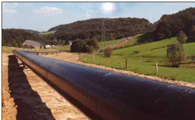
油气管线泄漏监测
