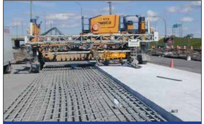
高速公路安全监测
