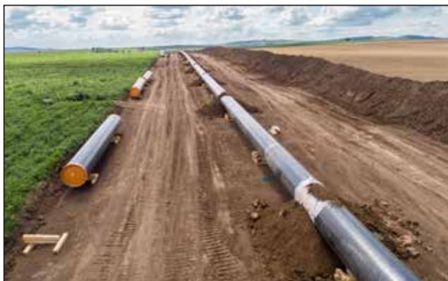
油气管线泄漏监测
